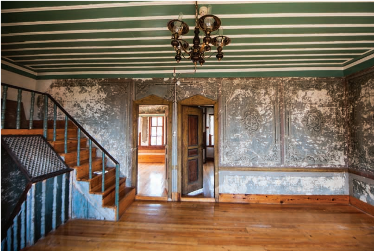
Geniş iç sofaya açılan batı uçtaki merdivenin sonu ve çatıya çıkan ek merdiven.
