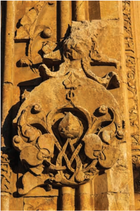
Külliyenin bir başka görkemli taç kapısı da batı cephesindeki anıtsal Darüşşifa Taç Kapısıdır. (Üstte Solda)
