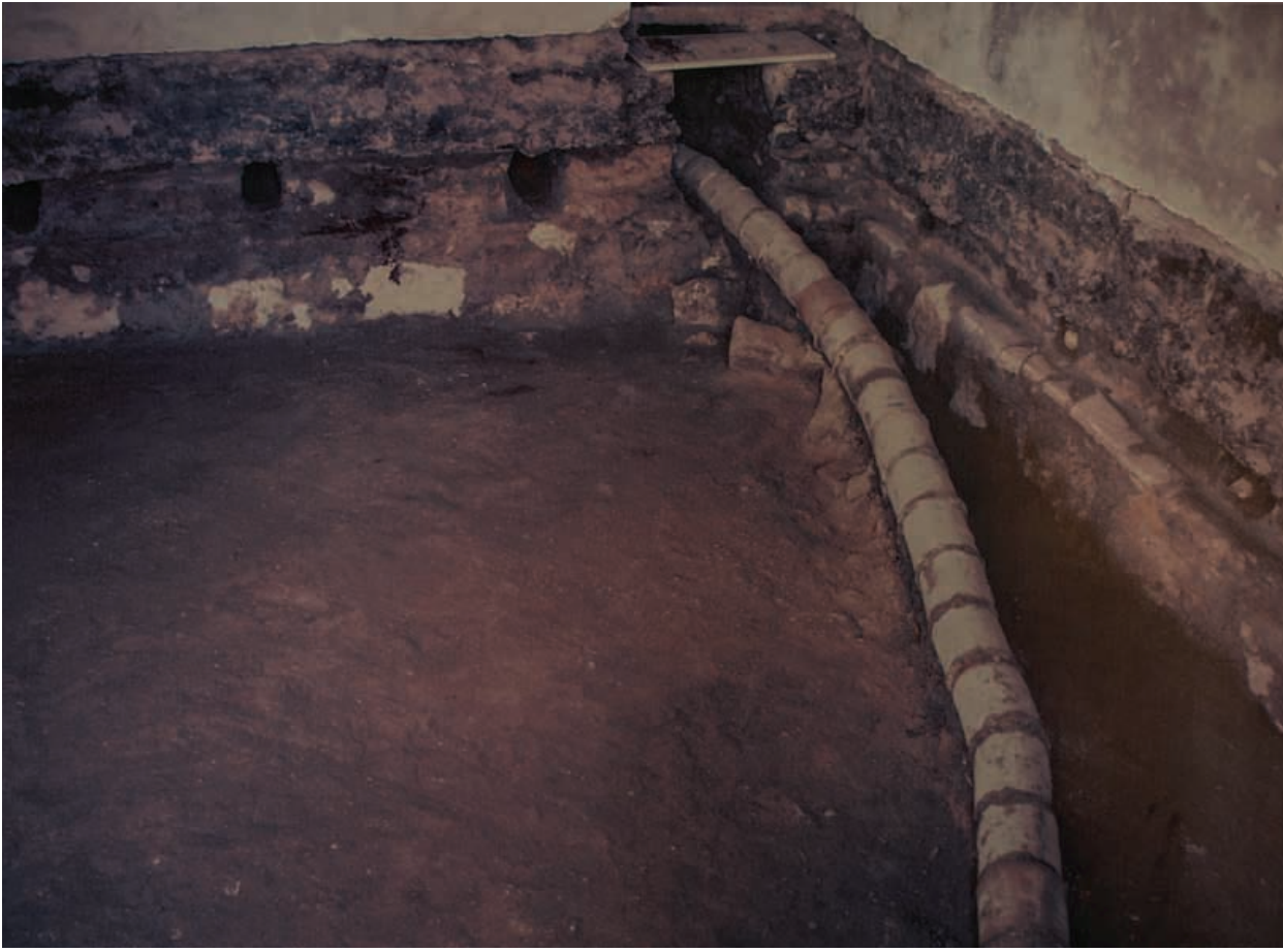
Kazılar sırasında ortaya çıkan ve üzeri henüz kapatılmamış olarak birbirine ekli durumdaki pişmiş toprak su künkleri. (Solda)
