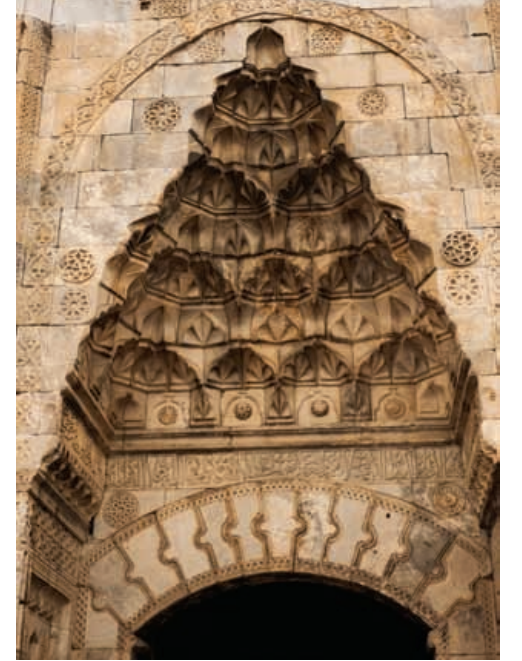
Kervansaray'ın dıştan sekizgen, içten ise yuvarlak olan ilginç kubbesinin alttan görünüşü. (Üstte)
