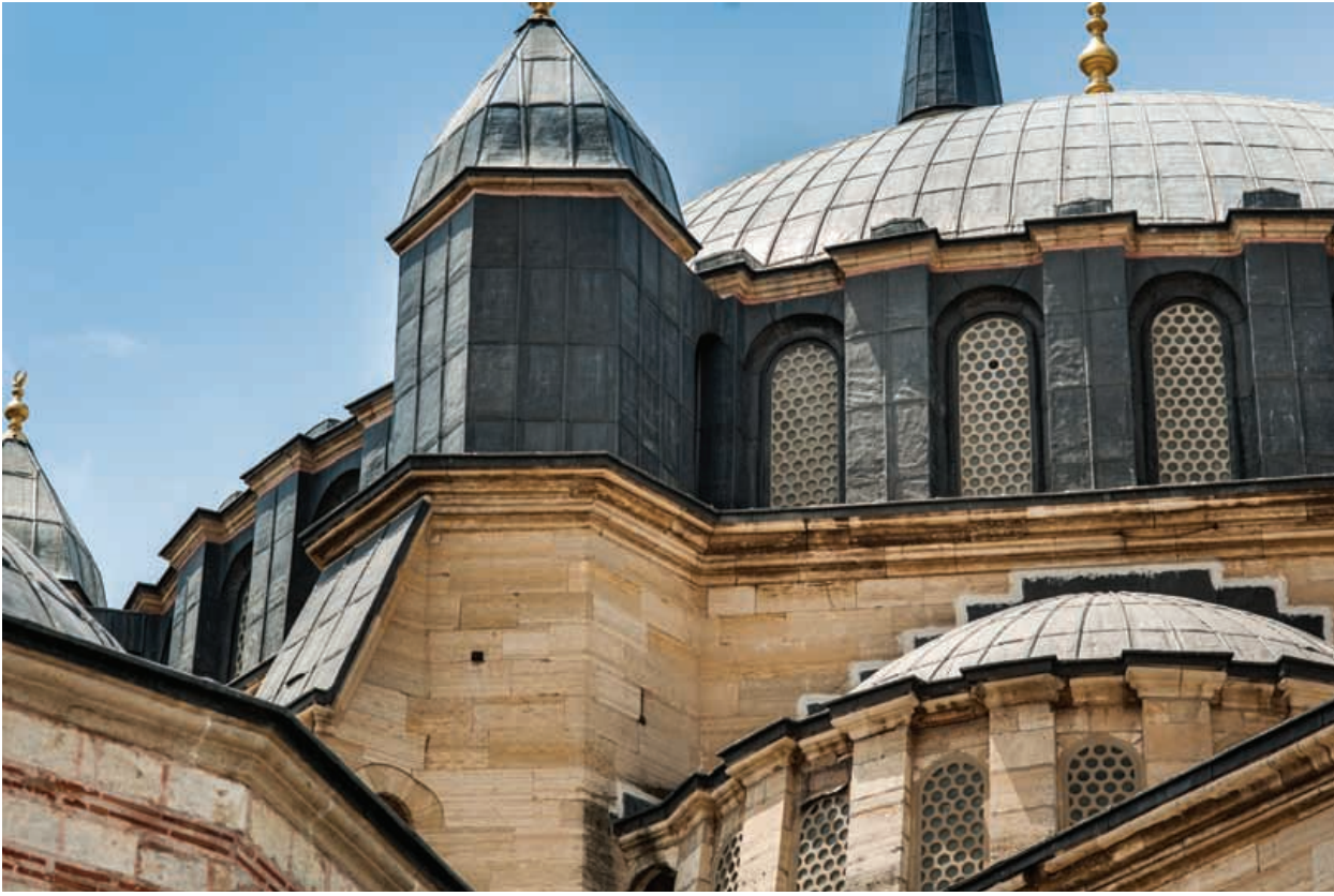
Caminin kubbe ve kubbe kasnağı ile önündeki denge kulesi ve alttaki yarım kubbeler. (Üstte)
