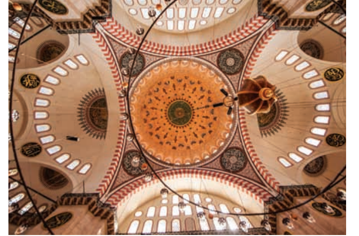
Süleymaniye'nin ana kubbesi ve kubbeyi yandan destekleyen yarım kubbeler ile doğu-batı cephesini oluşturan pencereci kemerlerin bütün olarak alttan görünüşü.
