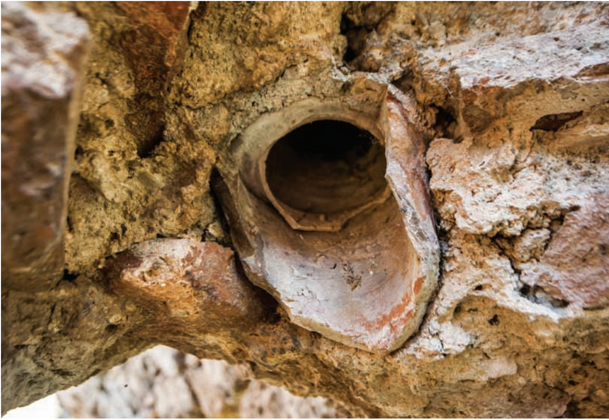
Duvar içinden geçen bir buhar ya da su künkü. Pişmiş toprak künk Miletos'taki Selçuklu hamamlarından birinden çekildi.
