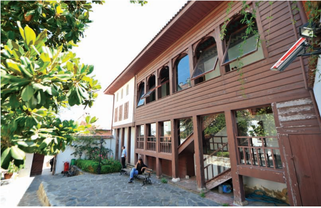
Konağın bahçeden ve batı cephesinin görünüşü.
