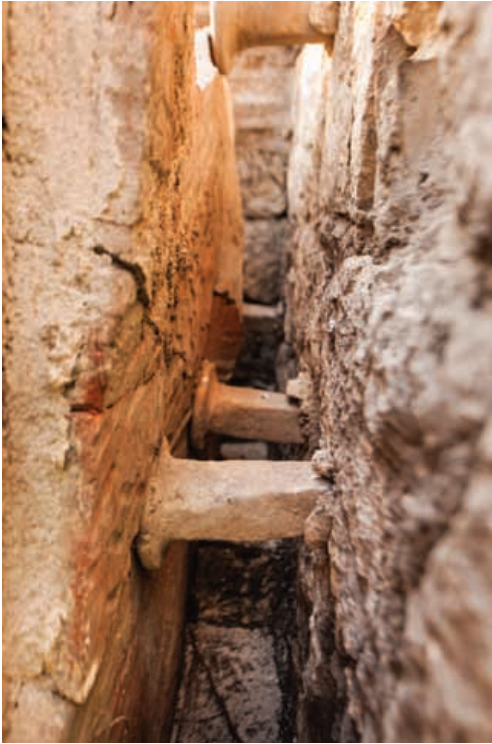
Küçük Roma hamamındaki mermer yıkama havuzu. (Üstte)
