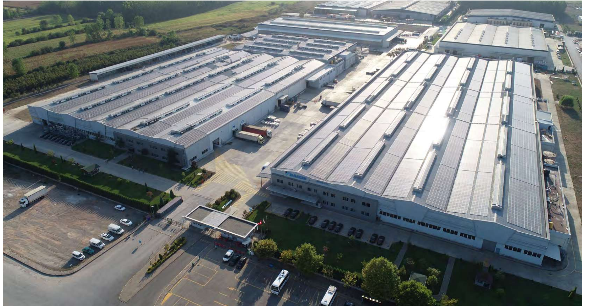
Daikin Türkiye Hendek Üretim Tesisi
